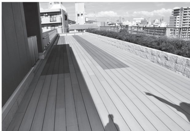
▲屋上テラスには歩行コースを設け、利用者が外へ出る意欲を引き出す環境をつくった
