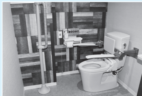
▲各フロアのトイレは、手すりの位置をすべて変えることで、どのような身体状態の利用者も使用可能に
